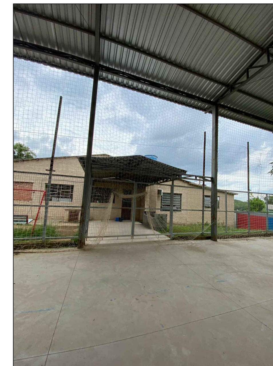
IMAGEM 01: FECHAMENTO LATERAL DA QUADRA COBERTA.
